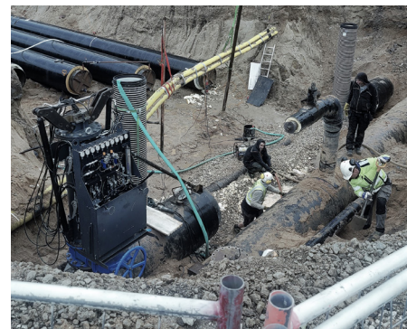
Ventilbytte vid kraftverket i Tartu, Estland.
