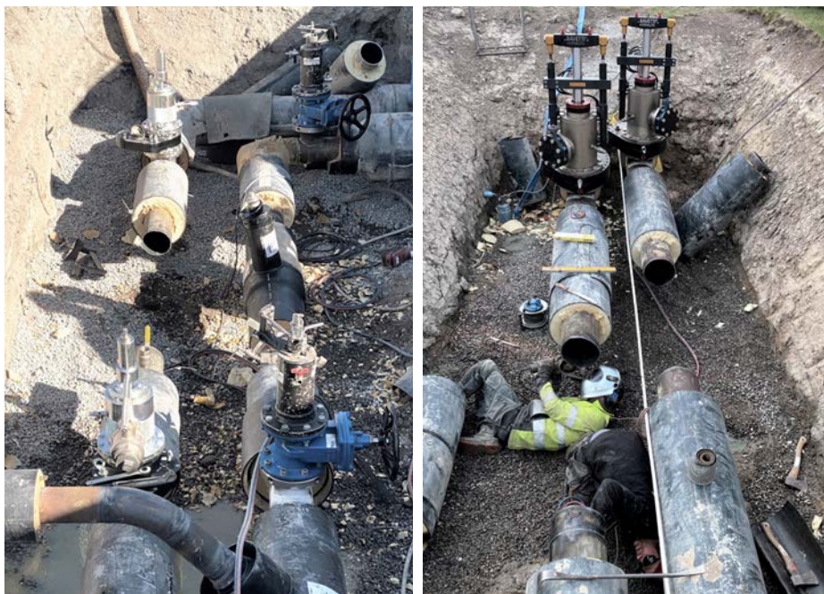
Ventilbyte med blockeringsteknik från Proco Services är ett bra miljöval.
