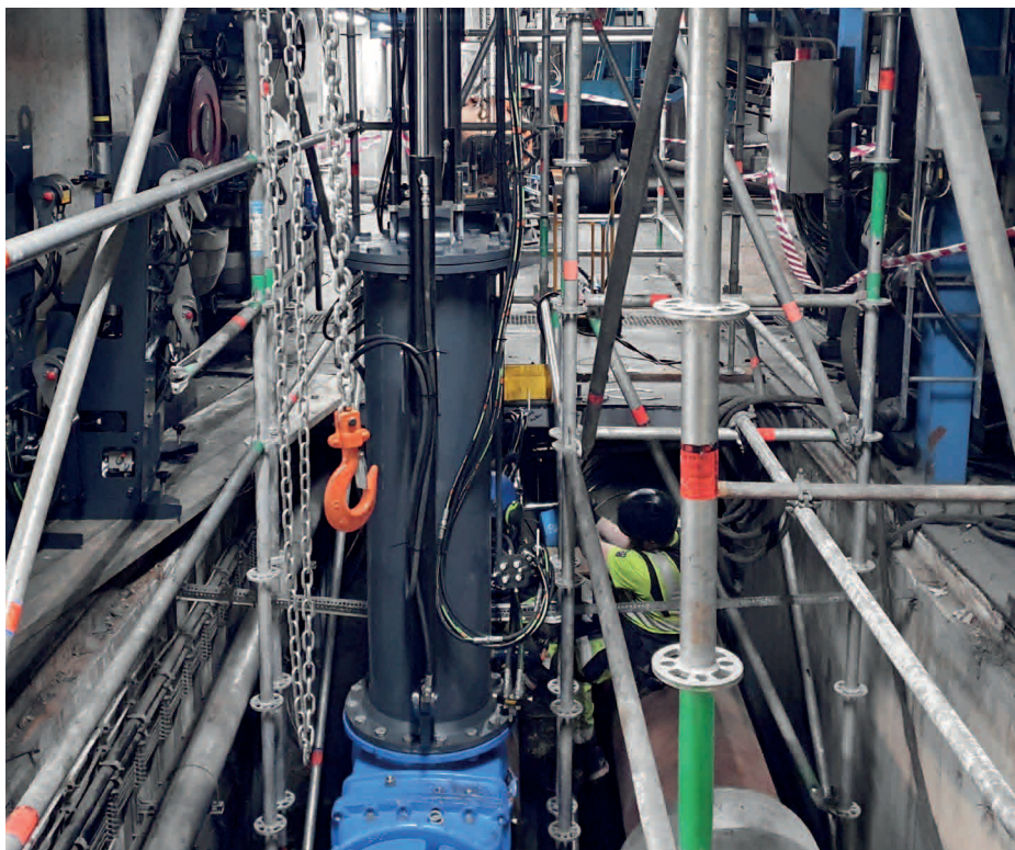
Proco Services dubbla DN600 blockeringar på tilloppsledningen i Igelsta värmeverk.
