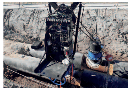
Proco Services DN500 verktyg inför blockering på Gotland.
