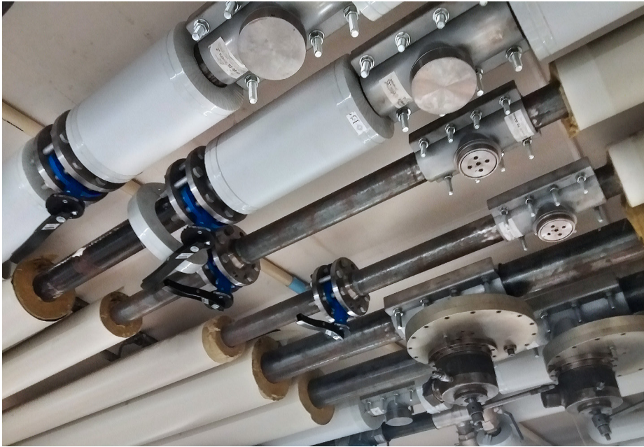
Snabb och smidig installation av sex stycken ventiler med hjälp av Proco Services teknik.
