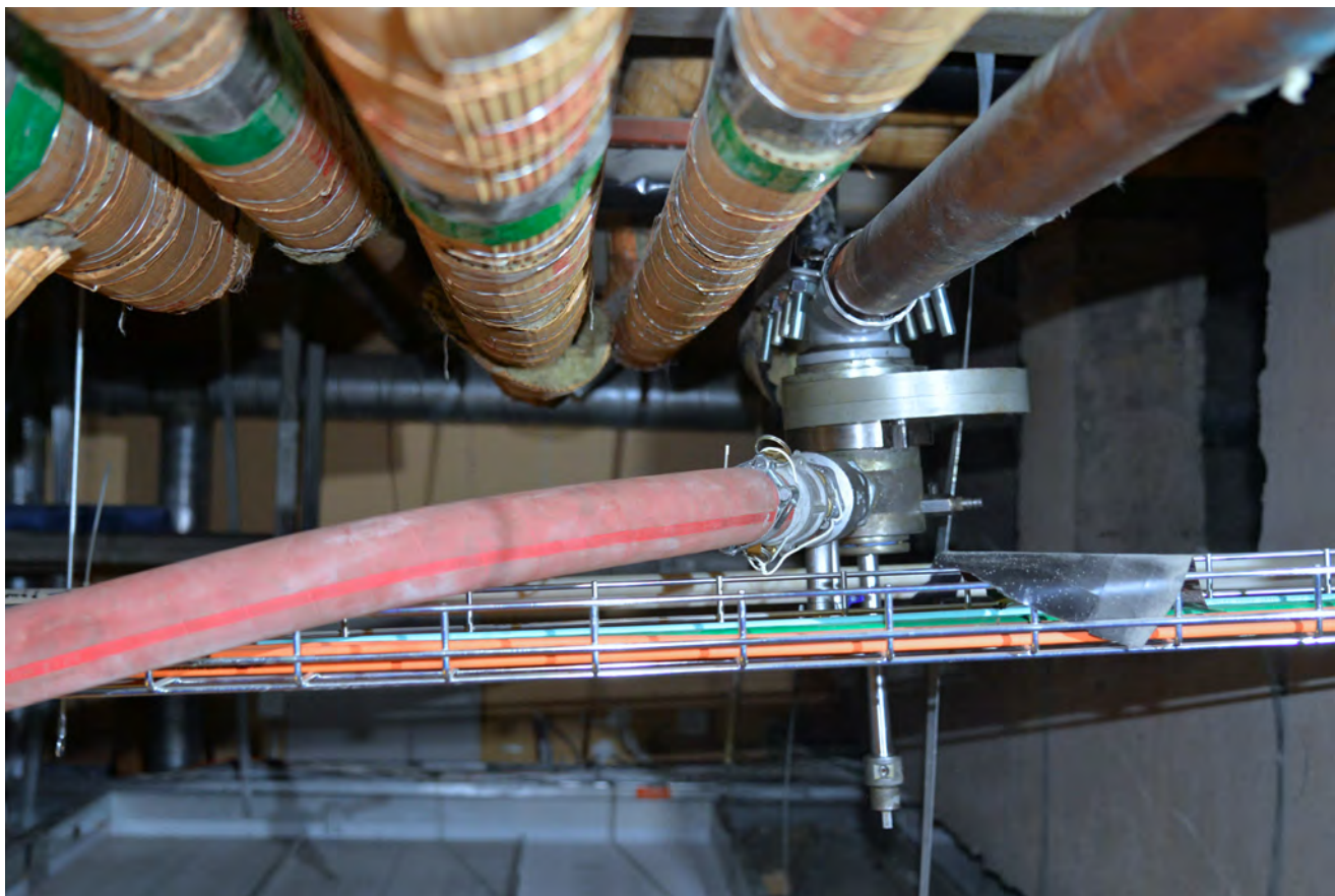
Proco Services blockeringsverktyg med inkopplad bypass.
