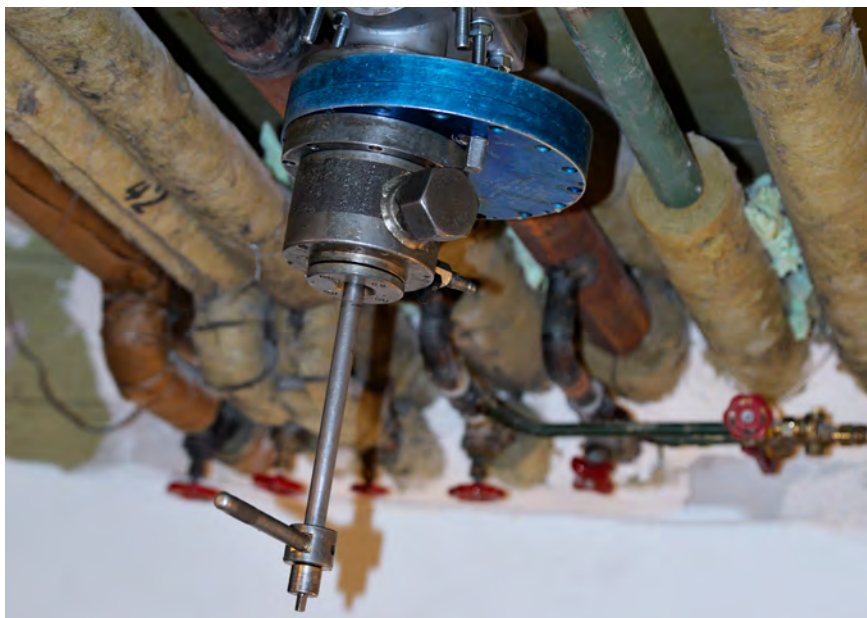
Blockering DN65 inför byte av undercentral i fastighet.
