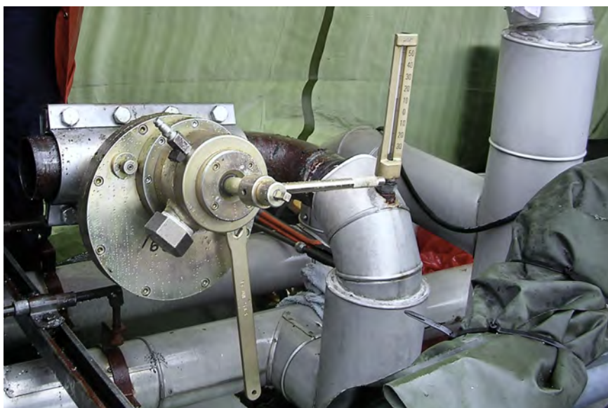
Blockering DN80 inför byte av kylanläggning till datorhall.
