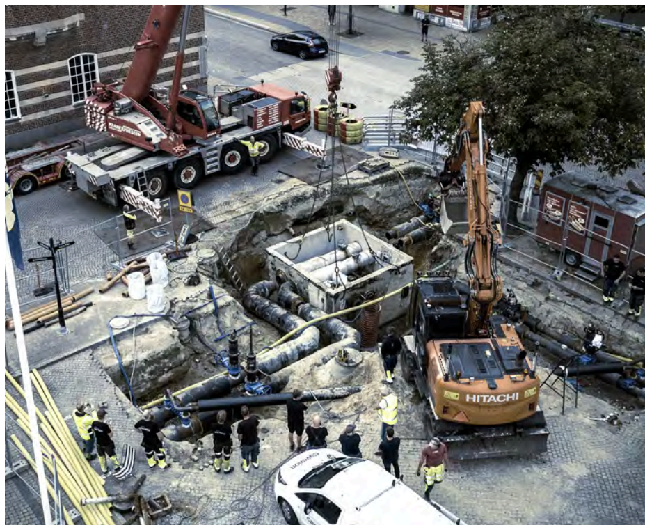
Proco Services teknik underlättar borttagning av fjärrvärmekammare i Kristianstad.
