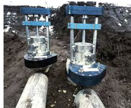
Blockering vintertid med 24 bars verktyg.
