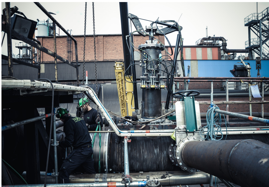
Med hjälp av Proco Services DN800-verktyg kunde ventiler bytas utan störningar i stålproduktionen.
