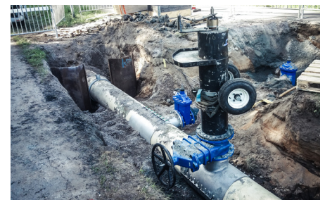
Proco Services teknik förhindrade utsläpp av avloppsvatten vid relining.
