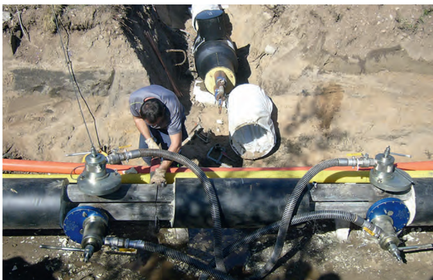
Blockering DN125 med by-pass inkopplad för avbrottsfri inkoppling av ny ledning.
