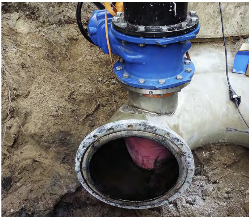
Till vänster: Ett aktivt blockeringsverktyg från Proco Services.
