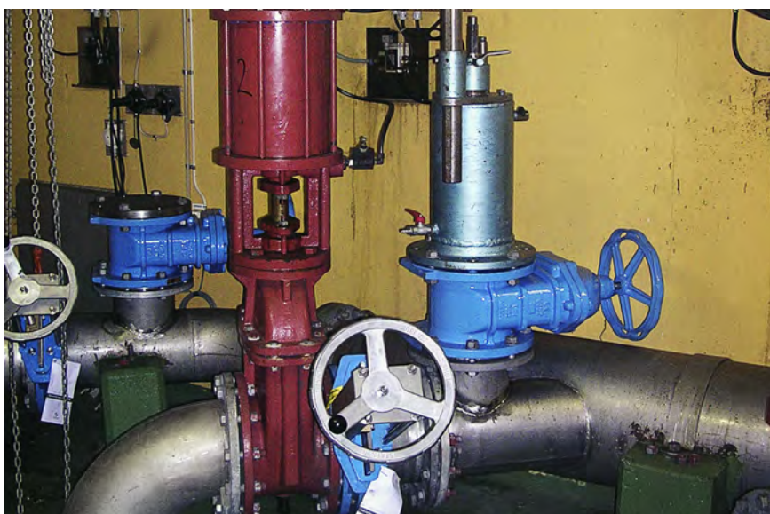
Blockering DN250 i pumpstation inför montering av nya ventiler.
