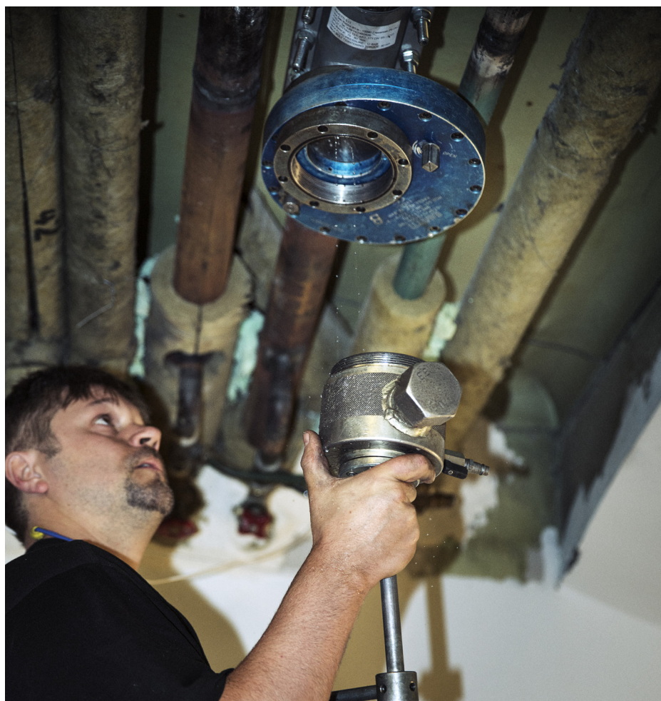
Blockering DN65 inför byte av undercentral i fastighet.
