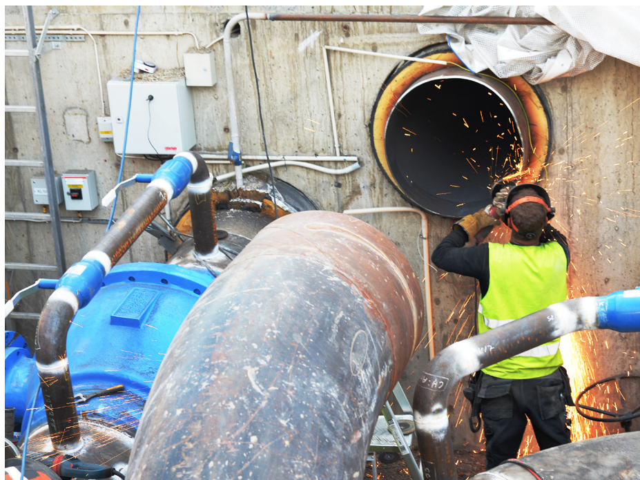
Proco Services erbjuder unika lösningar vid avancerade rörarbeten. Som uppdraget på Högdalenverket, ett av Sveriges största fjärrvärmeverk.
